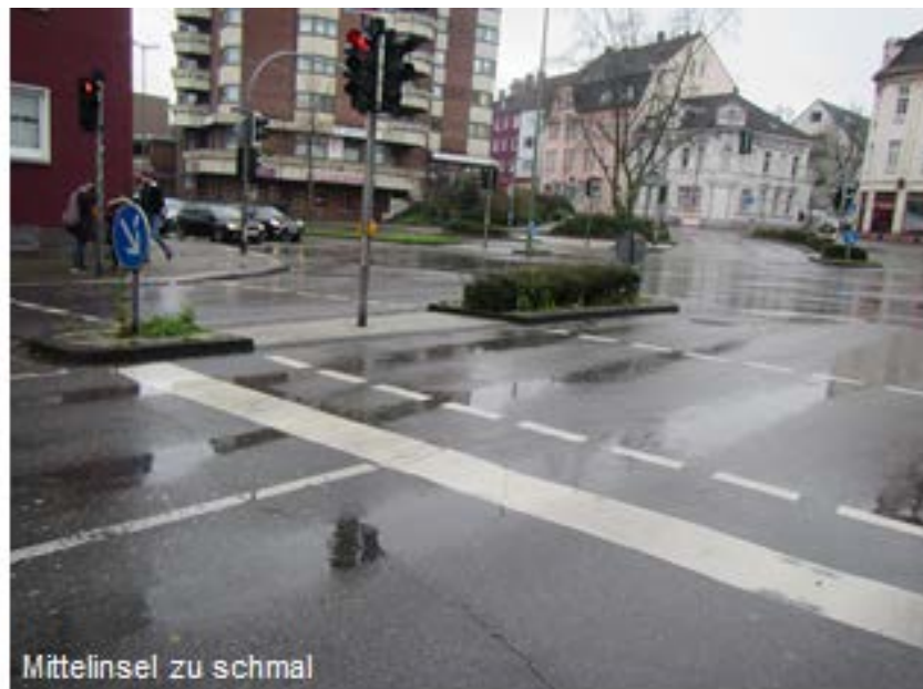
Abbildung 4-13: Deutlich zu gering bemessene Mittelinsel
