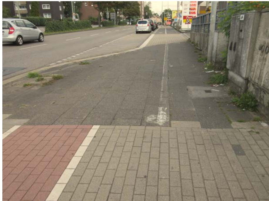
Abbildung 4-6: häufig ist in Bottrop ein aufwändiger Umbau der Nebenanlagen erforderlich
